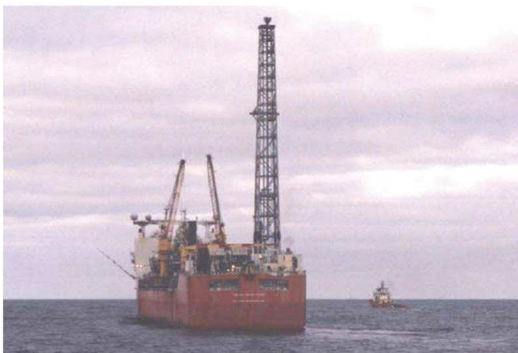
Figure A-16 L'unité flottante de production, stockage et déchargement en mer (FPSO)
